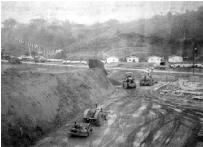
Início da terraplenagem da Unidade 2, em 1986
